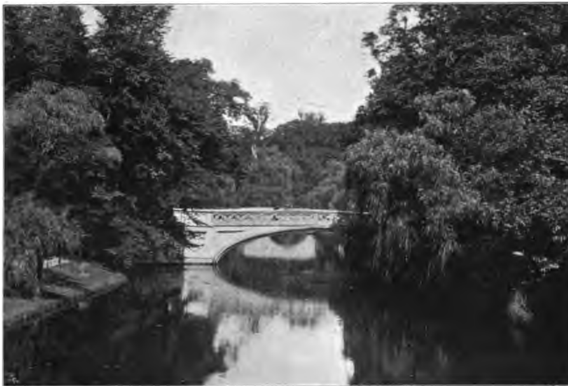
Brücke im Parke des College zu Cambridge.
