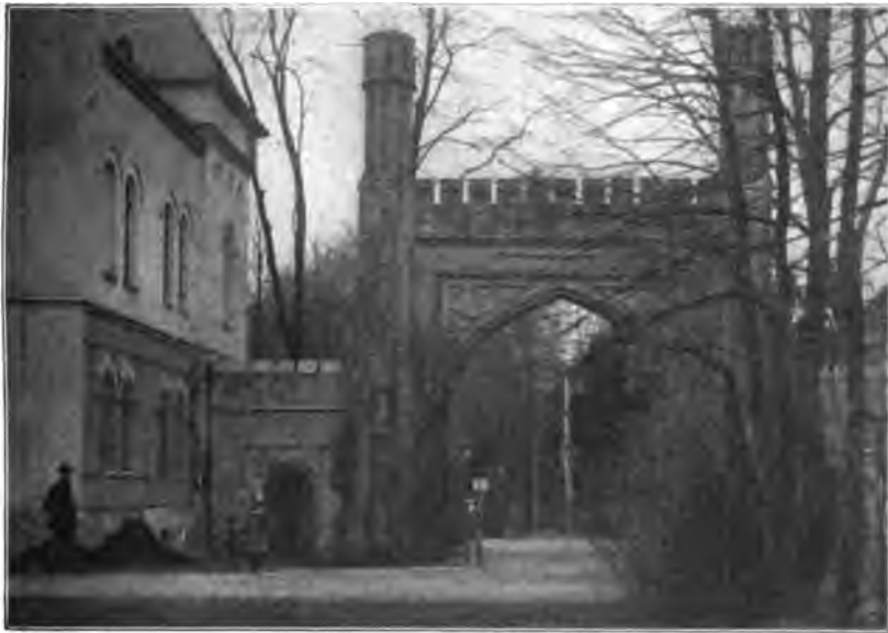
Haupteinfahrt in den Park zu Naklo. Links Obergärtnerwohnung
