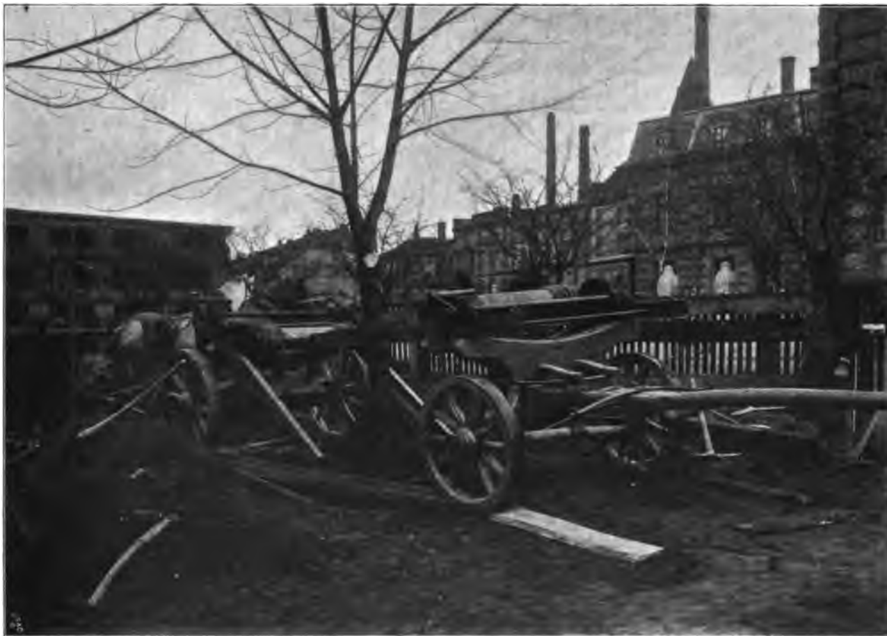
Verpflanzwagen, nach den Angaben des Herrn Stadt-Garteninspektors Ries, Karlsruhe, in der Wagenfabrik von G. Bankelmann, Dortmund, angefertigt. Originalaufnahme für „Die Gartenkunst“.
