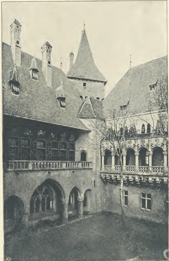
Abb. 146. Der Arkadengang der gothischen Gebäudegruppe.
