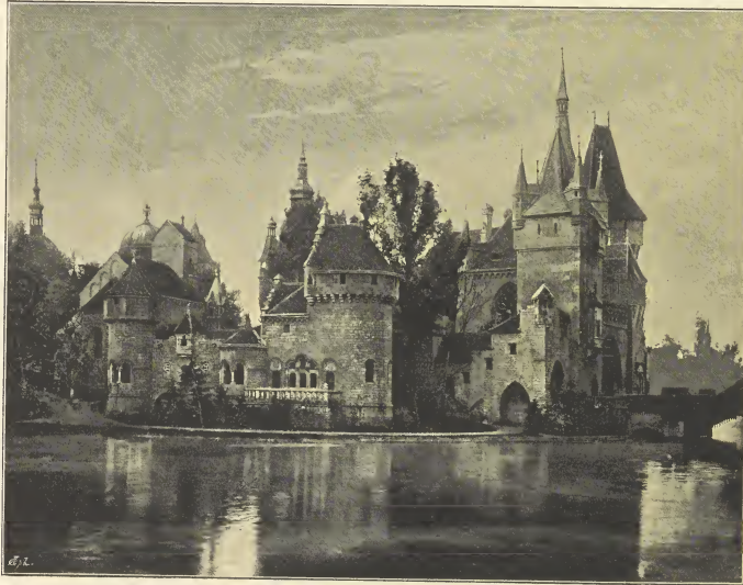
Abb. 100. Die romanische Gebäudegruppe. Von der Teichseite.
