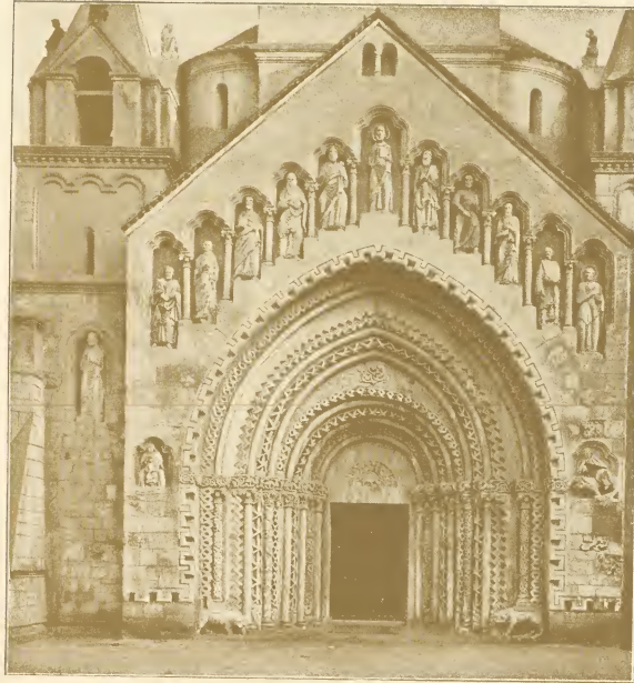
Abb. 27. Das Hauptportal der Kapelle. (Das Prachtthor der Jaáker Kirche.)
