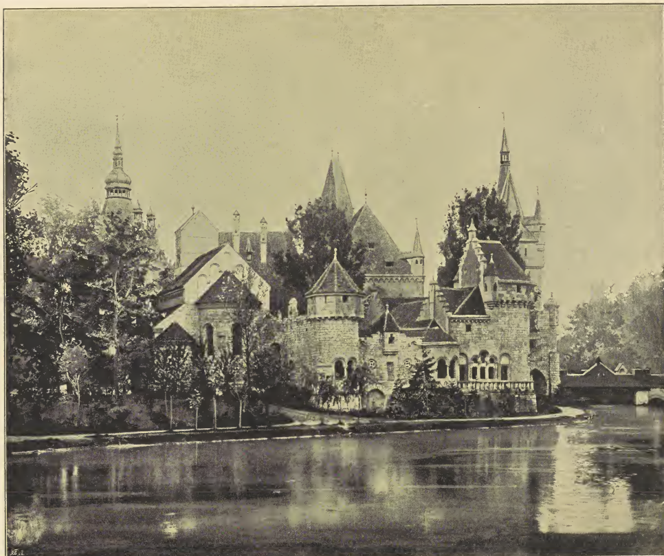
Abb. 1. Die Gebäude der historischen Hauptgruppe. Rückansicht.
