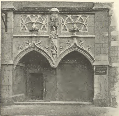
Abb. 145. Seitenthüre des gothischen Gebäudes.
