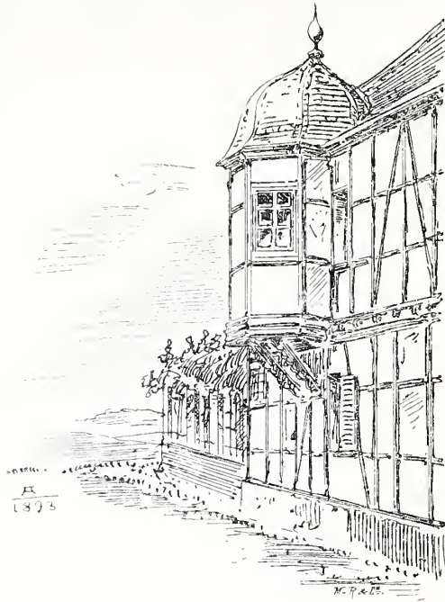
Fig. 70. Wormersdorf. Klein-Altendorf, Erker am Wohnhause.
