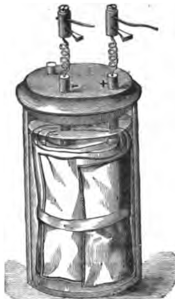
Fig. 230. Faure's Sekundär-Element.
