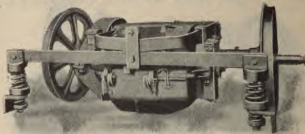
Fig. 70. Ansicht der federnden Aufhängung.
