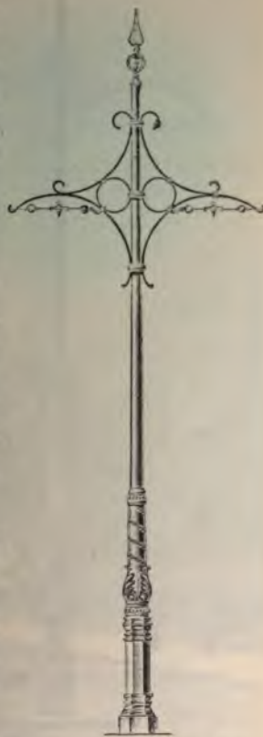
Fig. 36. Verzierter eiserner Mast.
