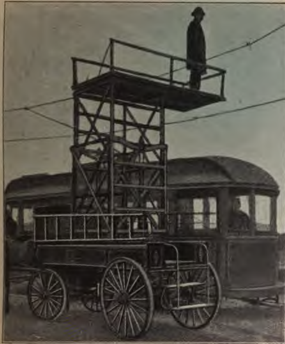
Fig. 49. Montagewagen englischer Bauart im Betrieb.
