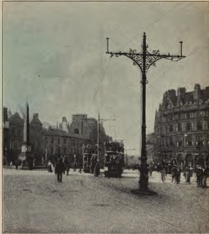
Fig. 39. Verzierter Mast mit doppeltem Ausleger für zwei Drähte.
