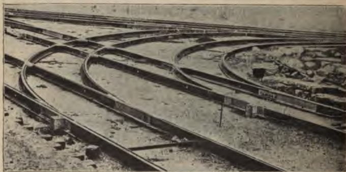
Fig. 10. Gerade Strecke mit abgehender Kurve.
