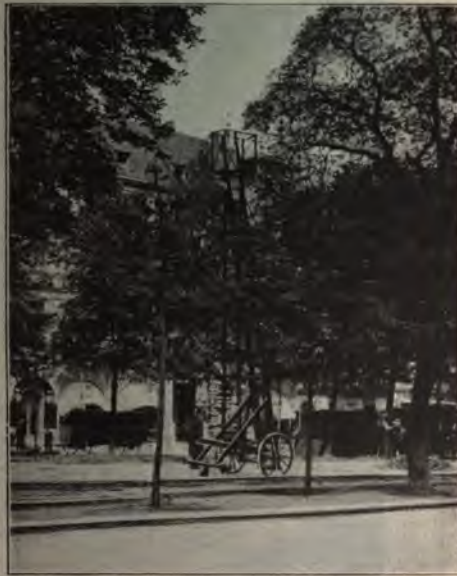
Fig. 52. Große mechanische Leiter.
