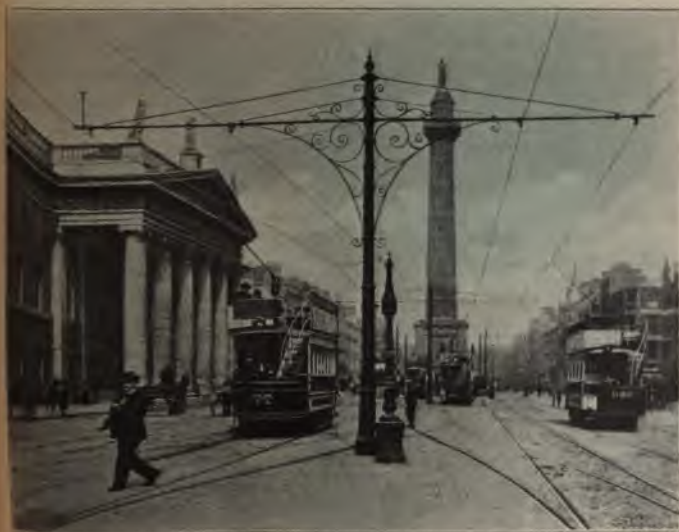
Fig. 38. Doppelter Ausleger für vier Drähte.
