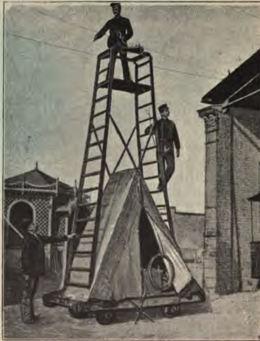
Fig. 43. Montagewagen der Halle'schen Straßenbahn.
