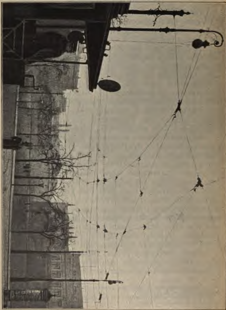
Fig. 120. Leitungskurven im Fahrdraht
