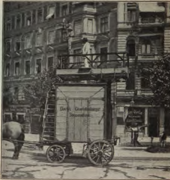
Fig. 50. Montagewagen von Siemens & Halske mit drehbarer Plattform. ]
