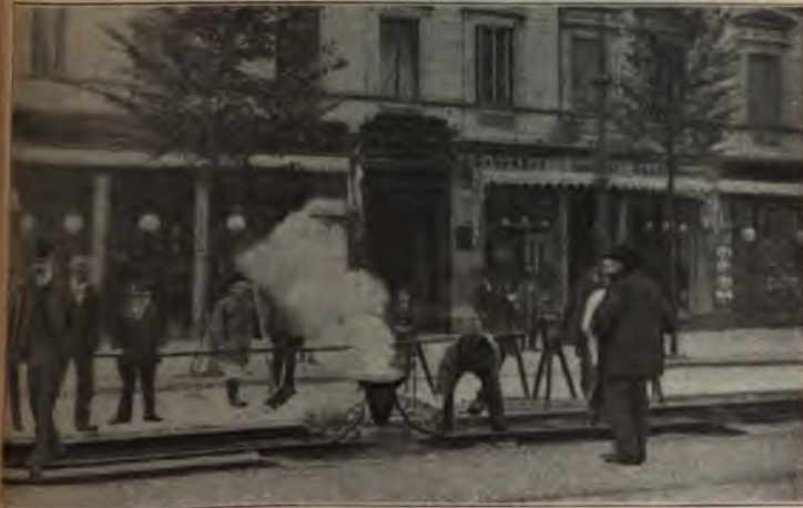
Fig. 18. Schienenschweißen mit Thermit.
