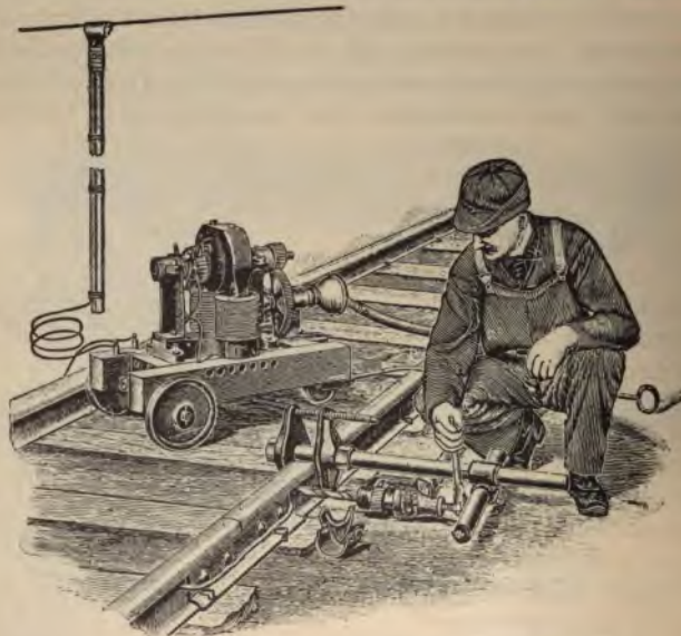
Fig. 17. Anbohren der Schienen für den kupfernen Verbinder.
