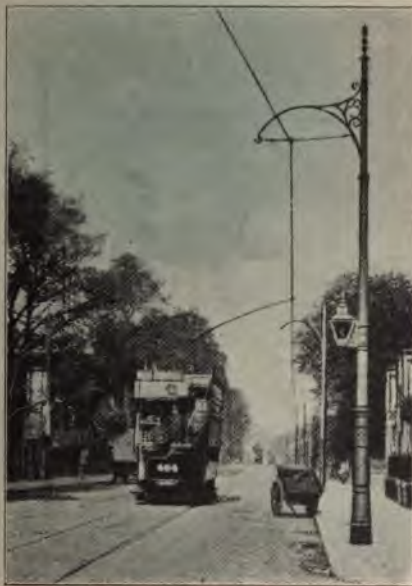
Fig. 40. Auslegermast für Dickinsonsystem mit einem Draht.
