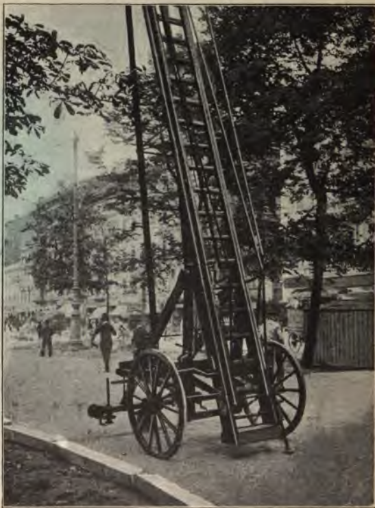
Fig. 53. Unterer Teil der großen mechanischen Leiter.
