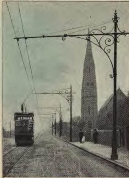
Fig. 11. Auslegermast für Dickinsonsystem mit zwei Drähten.
