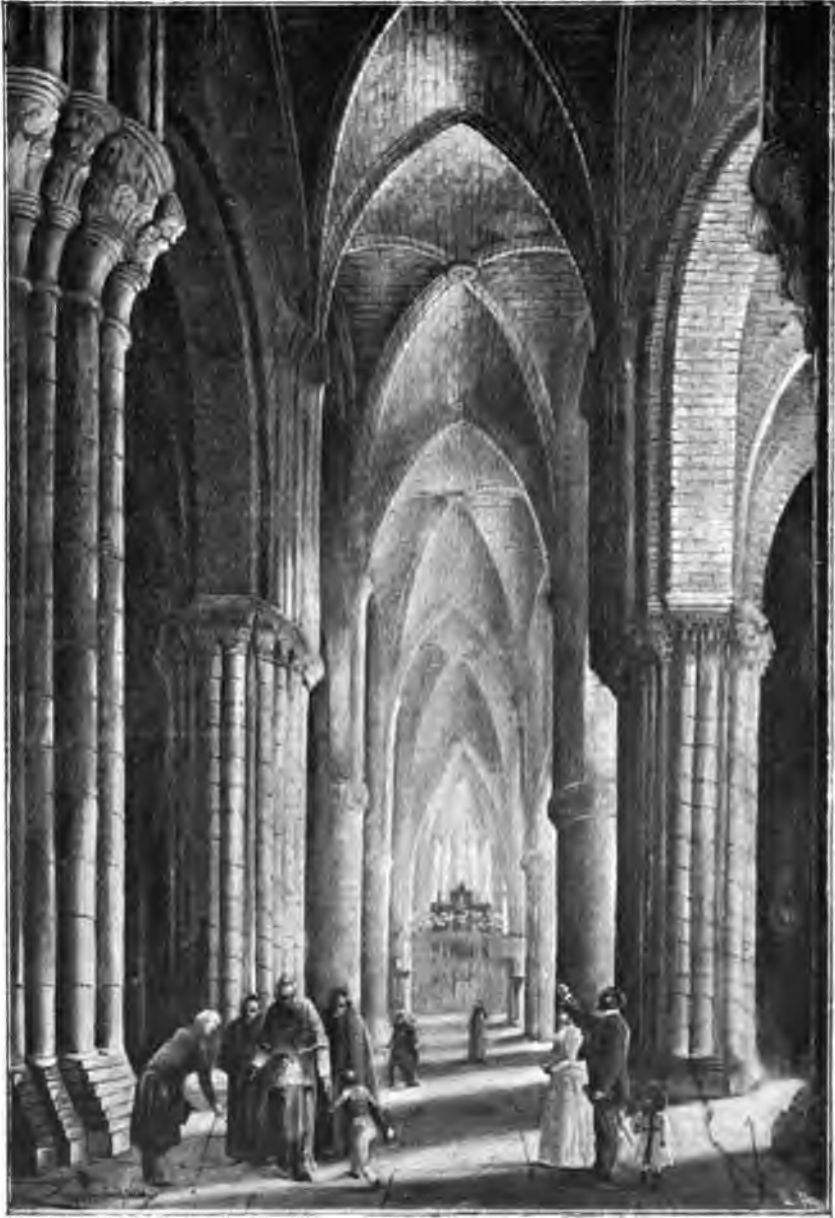
LA NAVE CENTRAL SIN LA CAPILLA DE NUESTRA SEÑORA DE LA MAYOR. Y SIN EL CORO.—(DE UN CUADRO AL ÓLEO QUE POSEE EL AUTOR)
