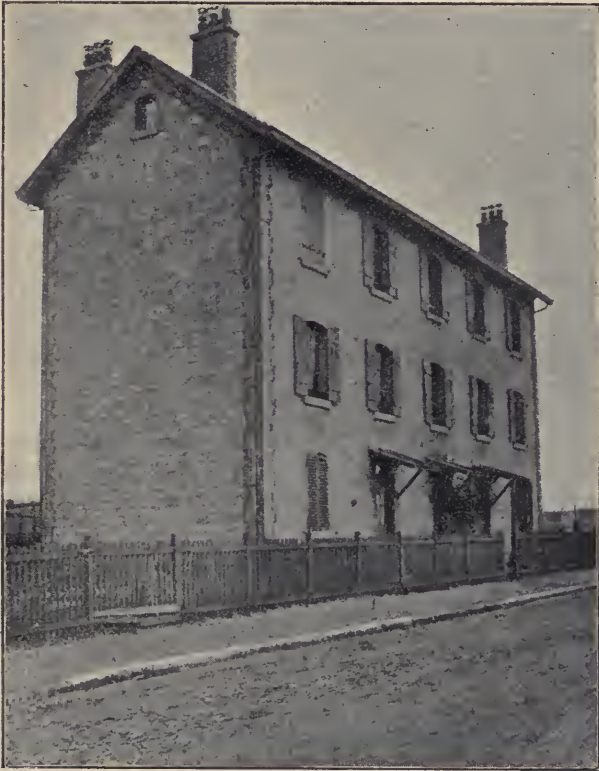
MAISON SISE A SAINT-OUEN, APPARTENANT A LA COMPAGNIE DU NORD ET HABITÉE PAR DES CANTONNIERS
