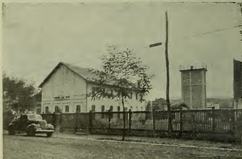
13. Wasserwerk in Cluj (Pumpenhaus in der Str. Gen. Eremia Grigorescu).
