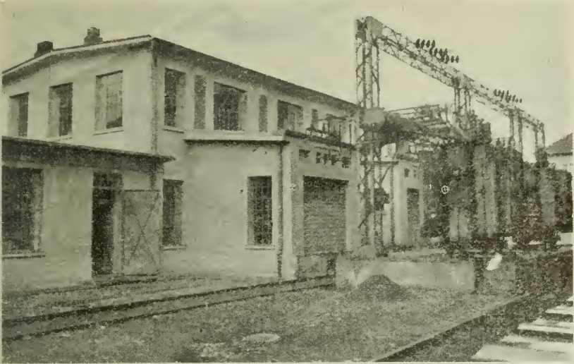
10. Das Kraftstromwerk in Cluj (Klausenburg), Transformatorenhaus.
