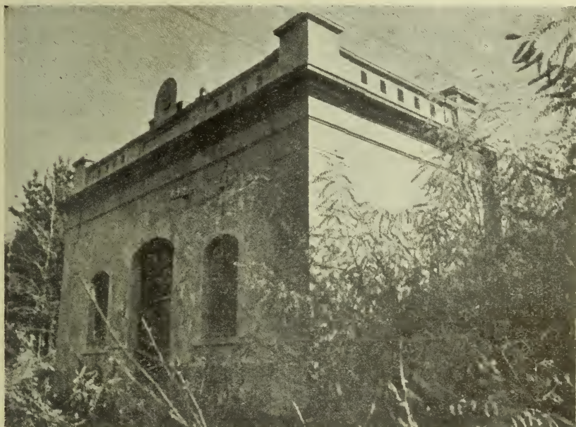
15. Wasserwerk, Cluj (Reservoir in der Str. Rahovei).
