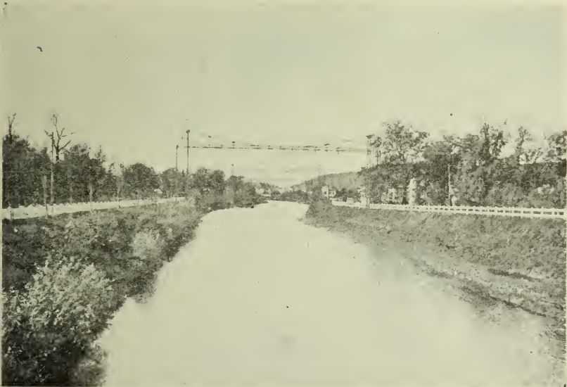
11. Kraftstromwerk in Cluj (Klausenburg), Leitungskabel für Kraftstrom.
